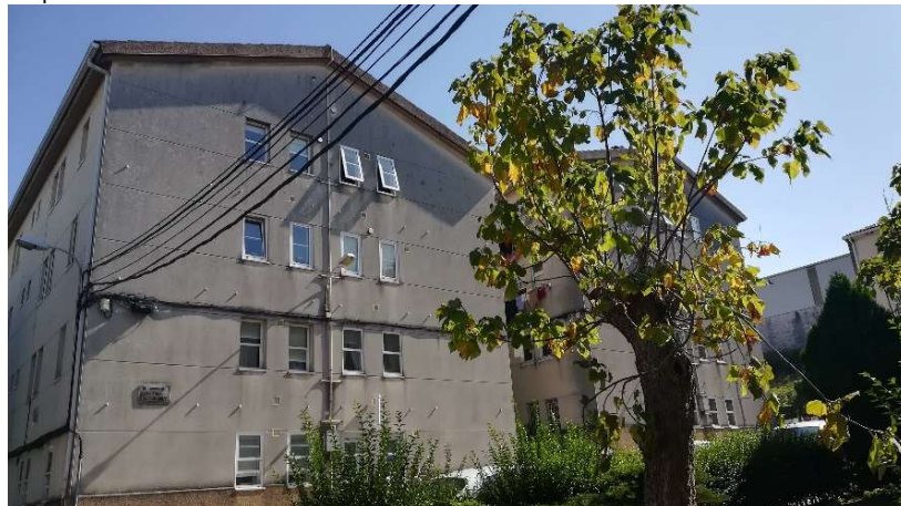
Fachada lateral dereita acceso ó edificio
