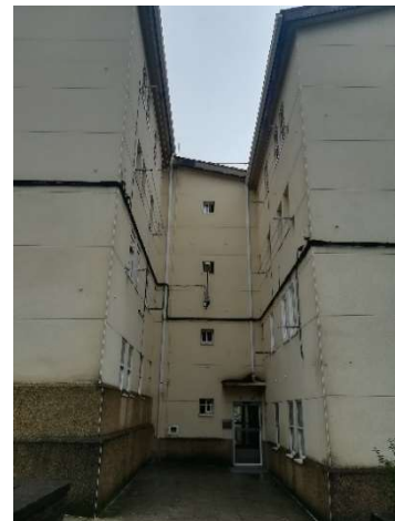
Patio aberto acceso
