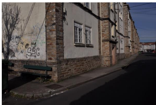
Acceso fachada principal portal 68. Foto tomada antes das actuacións de mellora nas fachadas
