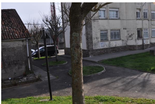
Acceso fachada traseira portal 56. Foto tomada antes das actuacións de mellora nas fachadas
