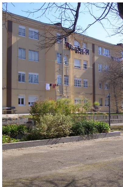
Fachada posterior. Febreiro 2023
