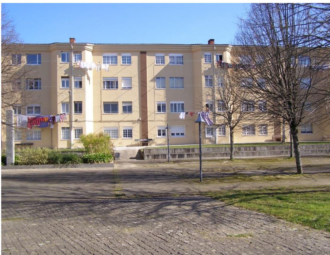
Fachada traseira. Febreiro 2023
