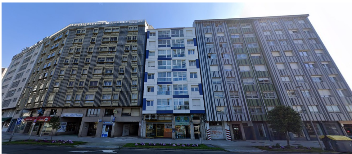
Imaxe 4. Vista dos edificios da avenida Romero Donallo
