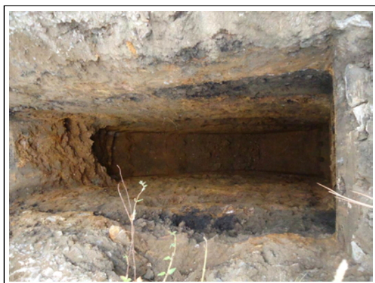
Aspecto de la excavación
