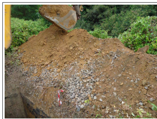
Detalle del material excavado
