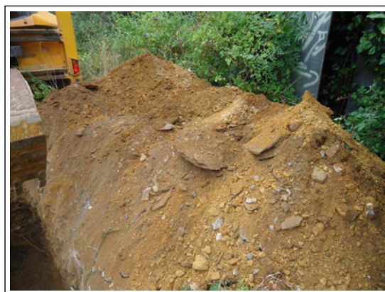
Detalle del material excavado
