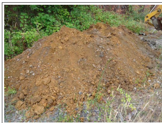
Detalle del material excavado
