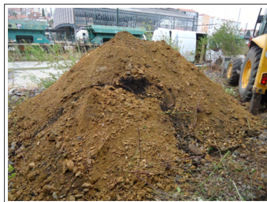
Detalle del material excavado
