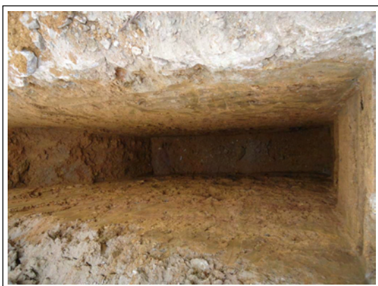
Aspecto de la excavación
