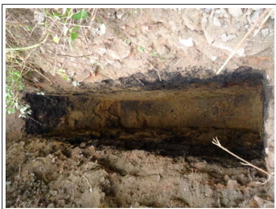
Aspecto de la excavación
