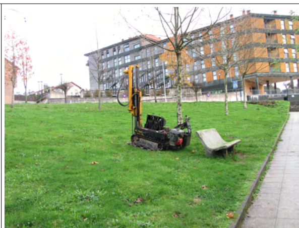
Ensayo de penetración PD-1
