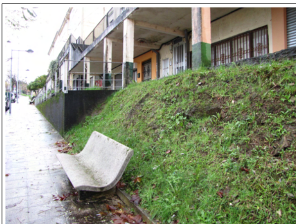
Afloramiento del sustrato rocoso alterado en talud rua Boiro
