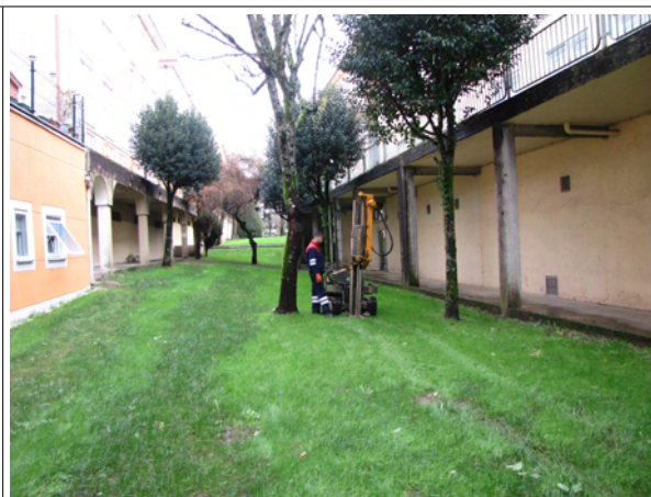
Ensayo de penetración PD-4
