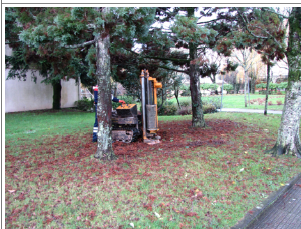
Ensayo de penetración PD-3
