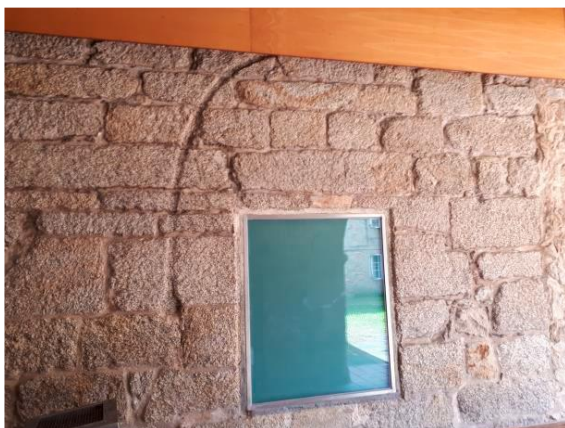
Alteraciones en el paramento del pasillo del claustro occidental
