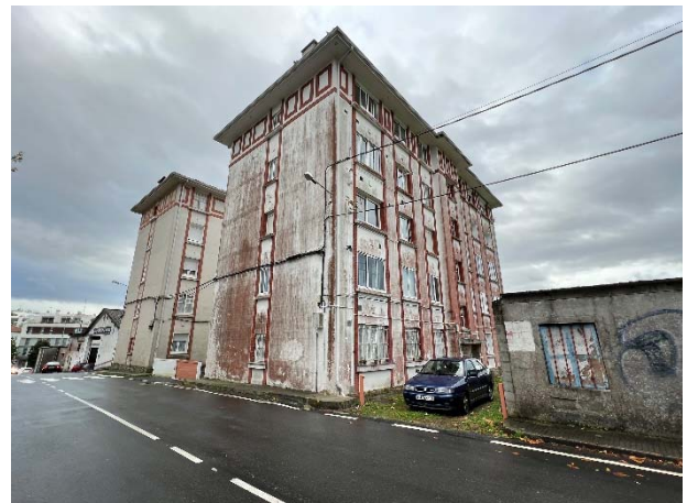
FACHADA LATERAL EDIFICIO Nº 4
