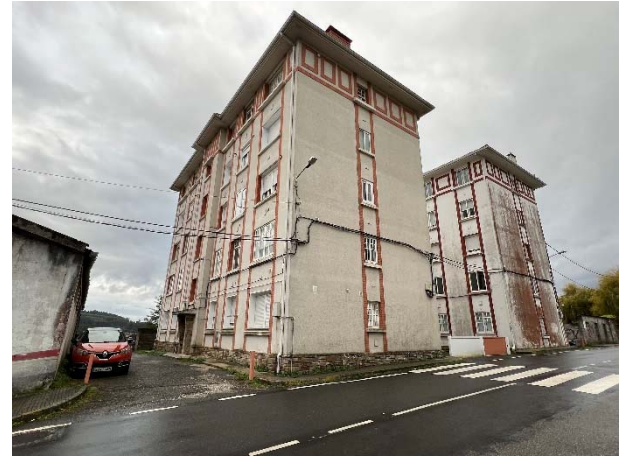
FACHADA PPAL Y LATERAL EDIFICIO Nº 3
